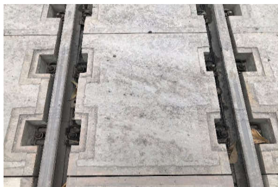
Bản bê tông dự ứng lực lắp đặt tại đường vào mỏ than Cọc 6 - Cẩm Phả - Quảng Ninh.
