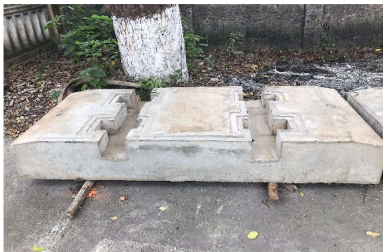
Kết cấu 01 bản bê tông dự ứng lực làm đường ngang.
